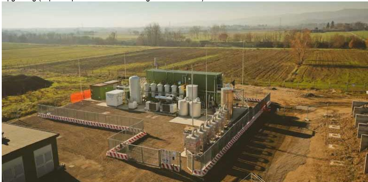
Upgrading (impianto per raffinazione da biogas a biometano)
